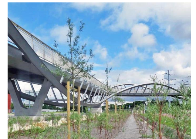
TEGEVAL BRIDGE Creteil, France
